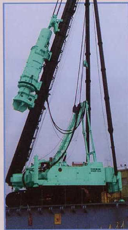
▲30Mリーダ斜杭作業
